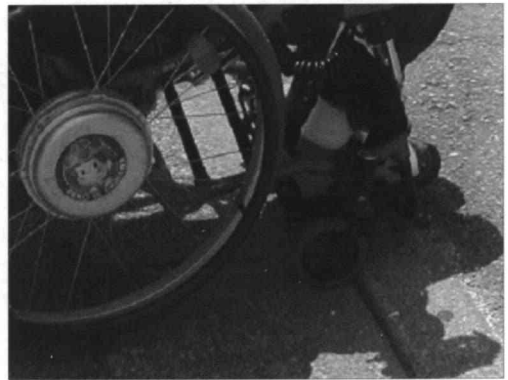
写真4-1 歩道と車道の段差
