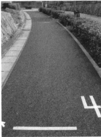
写真3.3 縦断勾配実験場所
