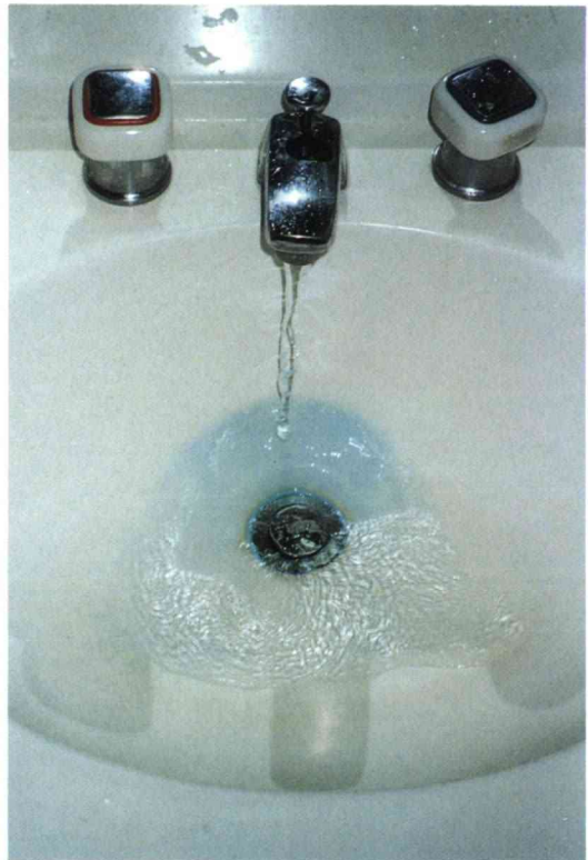
写真 2 洗面槽の着色
